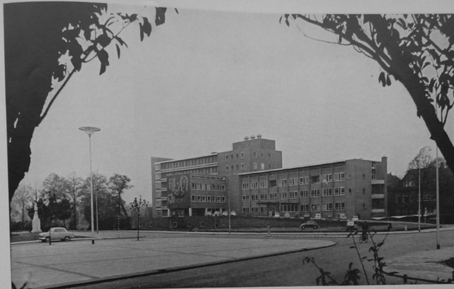
1 Voorgevel van het nieuwe complex uit het oosten gezien
